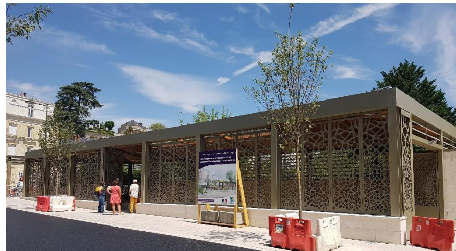
Halle ouverte à Vouvray s/Loire (37)
