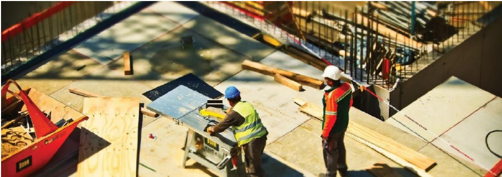
Figure 10 Construction et réhabilitation de nouveaux logements
